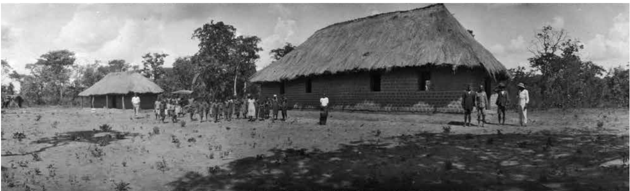
Abris temporaires élevés sur l'avenue Likasi en juillet 1925 par R.S. Guptill. (HP.1957.53.417, collection MRAC Tervuren ; 1925.)
