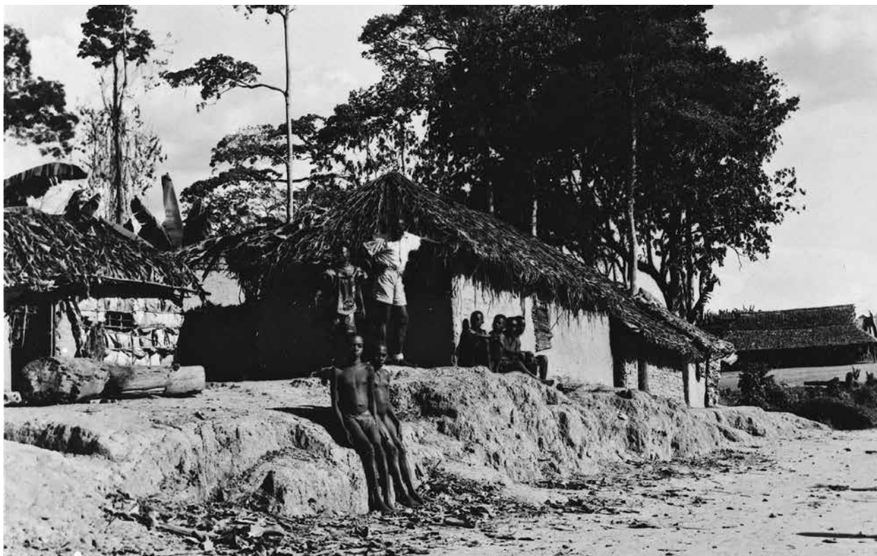
Une avenue de Kambove en 1918. (HP.1956.15.285, collection MRAC Tervuren ; photo E. Gourdinne, 1918.)
