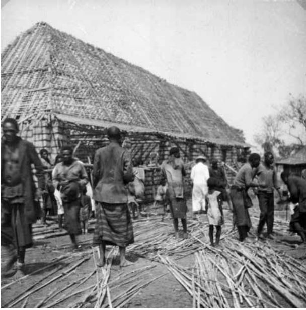
Août 1931 : construction à Kanzenze de la chapelle-école. (HP.2011.62.13-281, collection MRAC Tervuren; photo G.F. de Witte, 1931, © MRAC Tervuren.)
