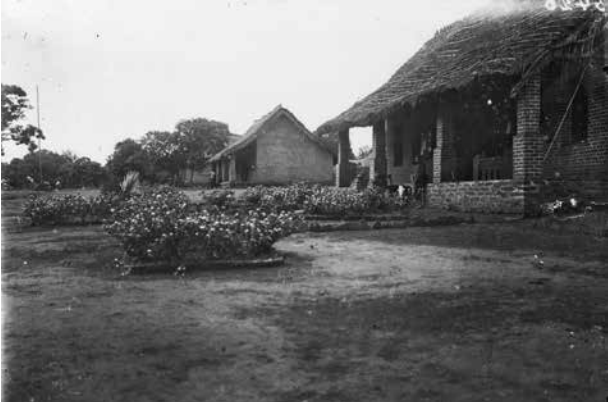
Le poste de Lukonzolwa en 1913. (AP.O.0.15426, collection MRAC Tervuren ; photo Vanderlinden, 1913.)
