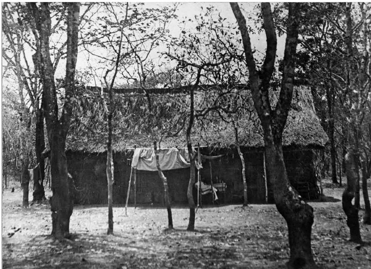
La première maison d'Élisabethville, celle du gouverneur Wangermée, construite sur le plateau où devait naître la capitale du Katanga. (HP.1956.15.502, collection MRAC Tervuren ; photo A. Van Iseghem, 1910.)
